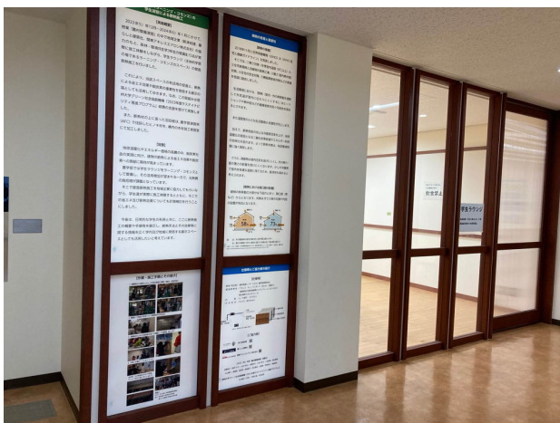
写真1：断熱・内窓施工したラウンジ
